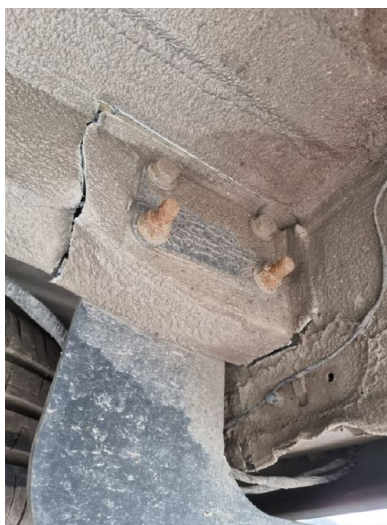
Obr. 21 – Pohled na poškození zadního podélníku Fig. 21 – View on the Rear Stringer Damage
