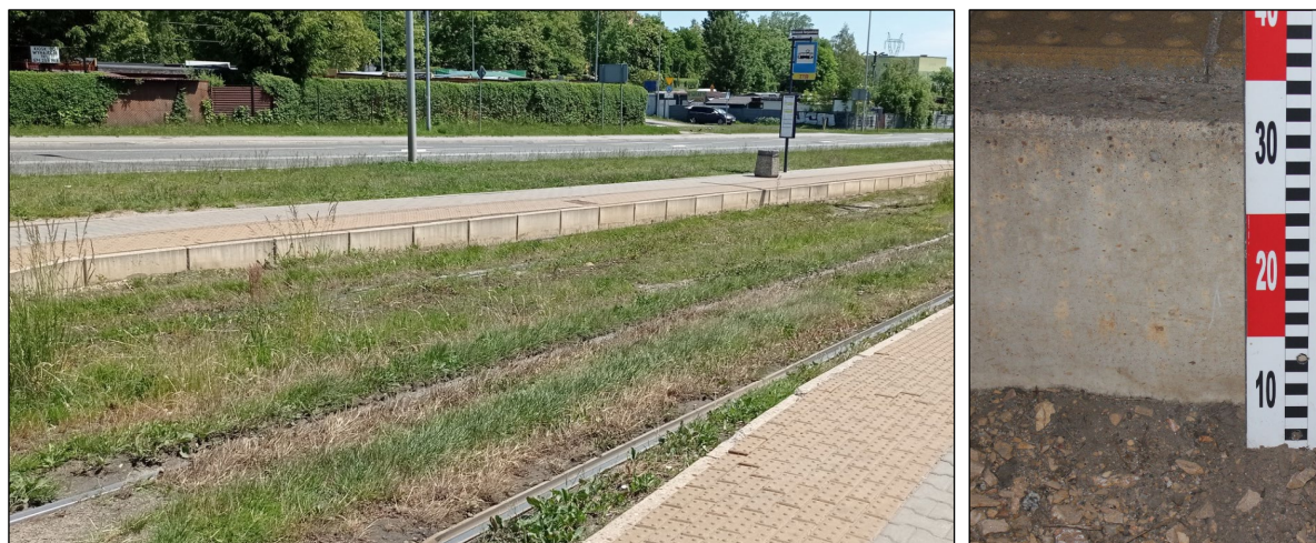
Obr. 8 – Peron po przebudowie.
