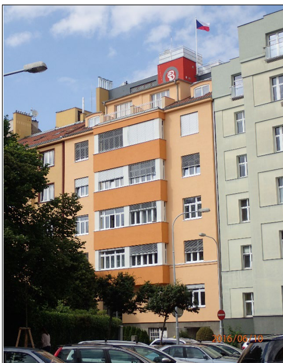
Obr. 4 – Rekonstrukce a zateplení bytového domu Bří. Čapků 12, Brno
