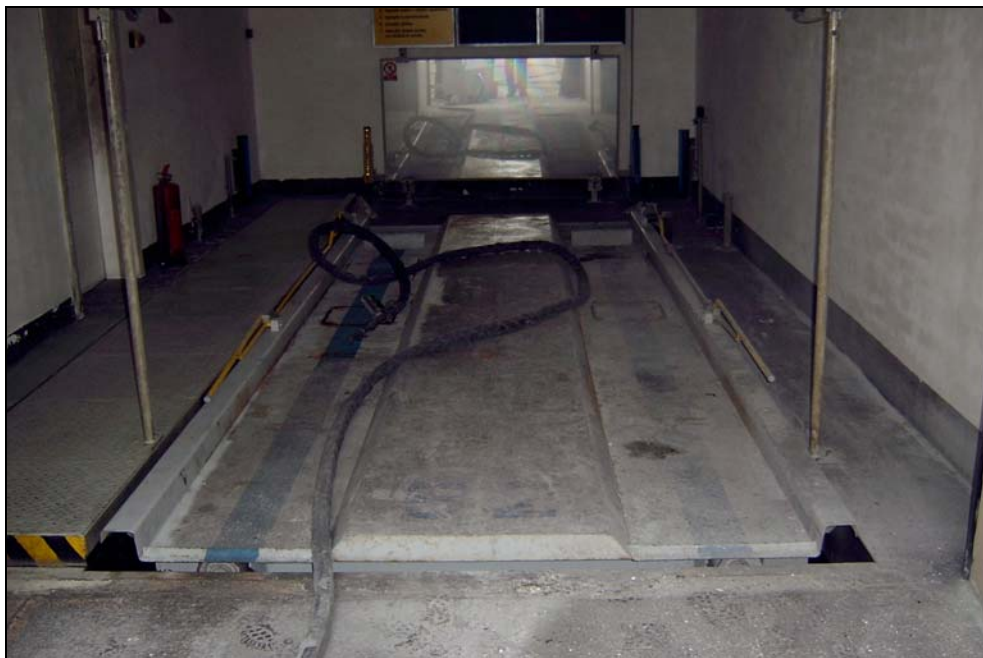
Obrázek 39 - Paleta na kterou najede garážované vozidlo, které se po příkazu garážovou kartou automaticky přesune do volné kóje podzemní garáže. Stejnou kartou se vozidlo přivolá do prostoru výjezdu.
