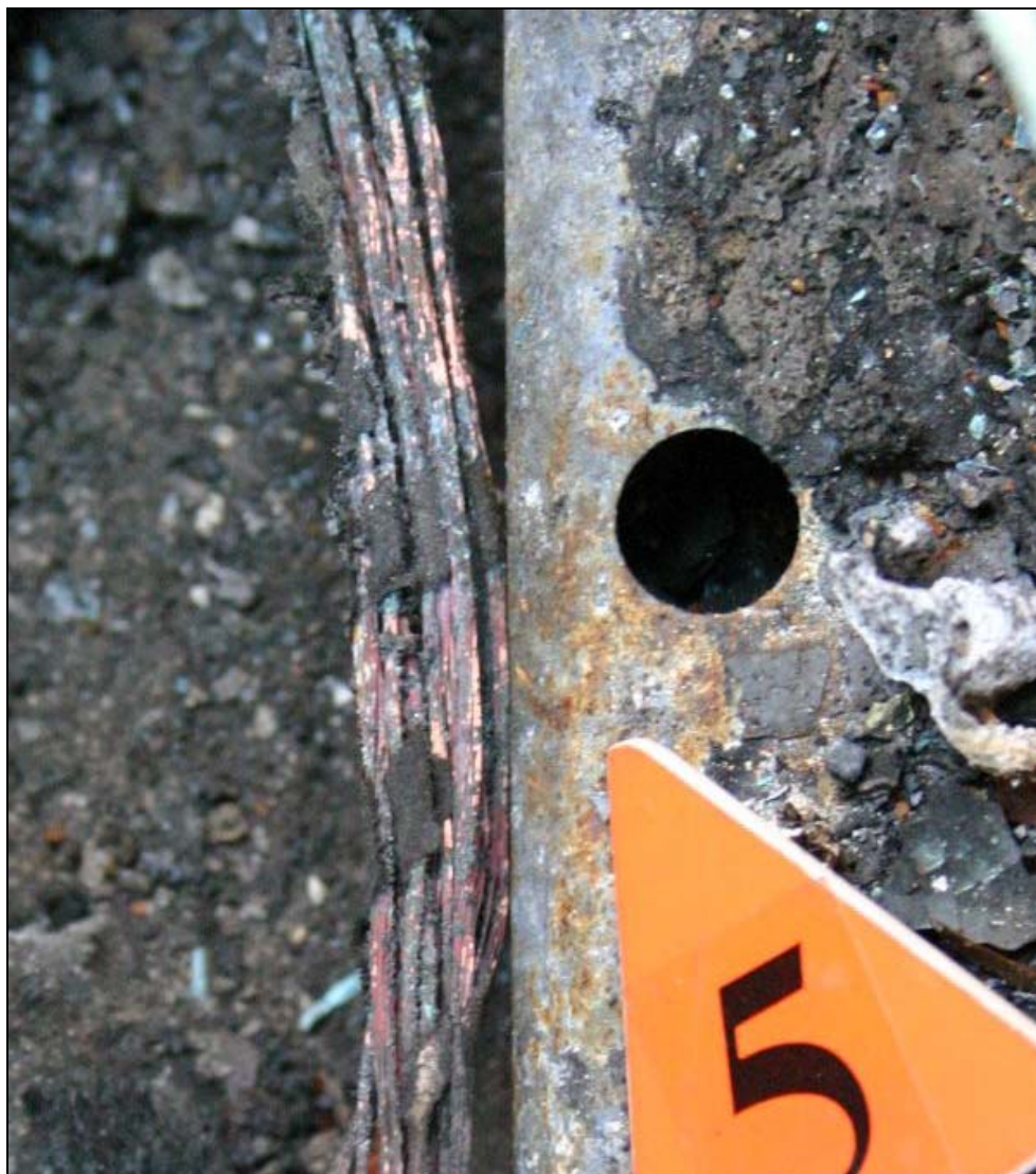
Obrázek 8 - Požárem poškozený svazek vodičů uložený u pravého prahového nosníku.
