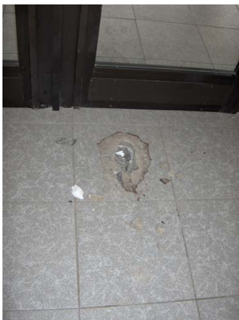
Foto č. 6 Sonda ve vstupním vestibulu
