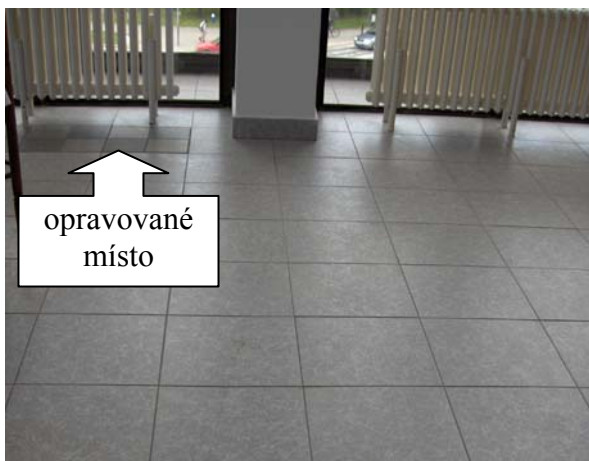
Foto č. 1 Opravovaná místa v podlaze
