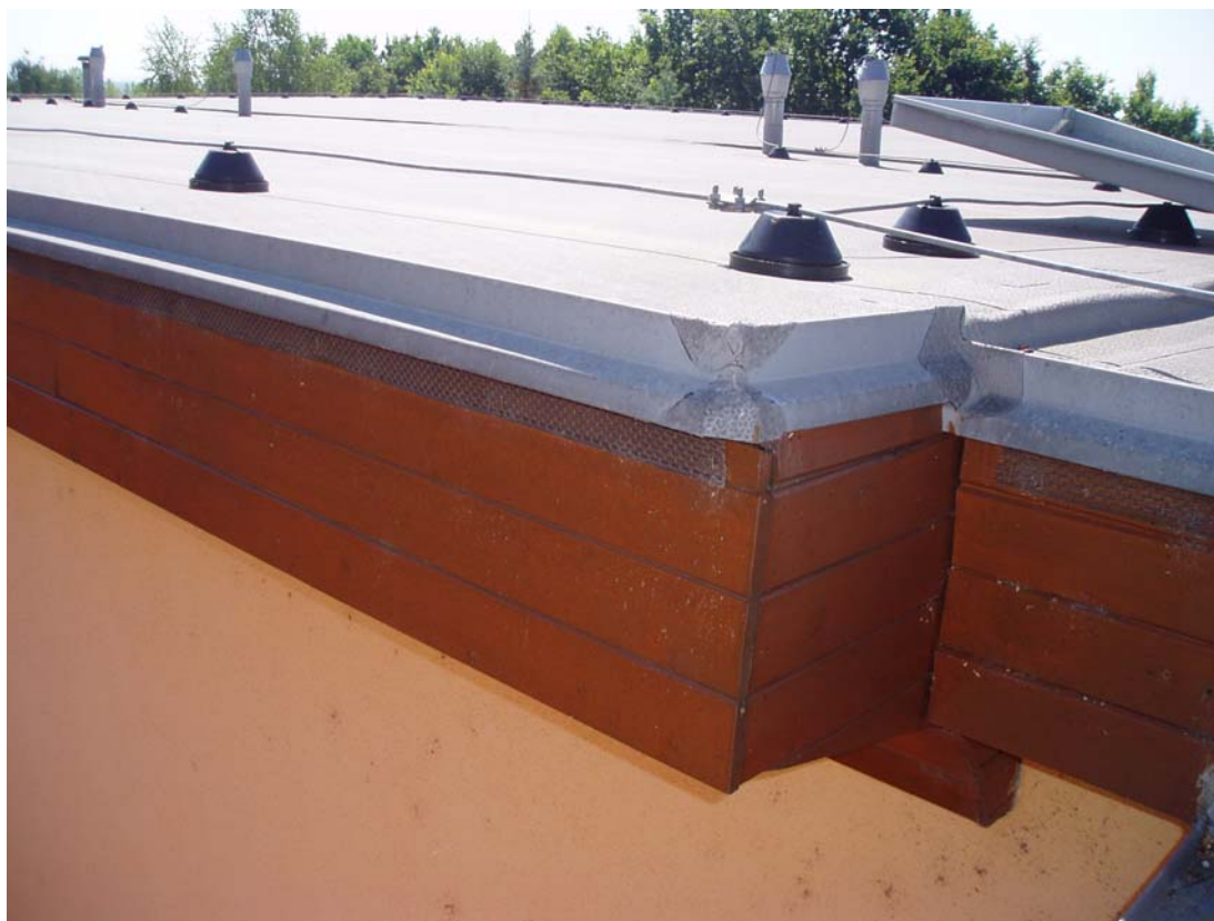
Foto 3 – Pohled na ukončení střechy s částečně provedeným průběžným otvorem krytým mřížkou
