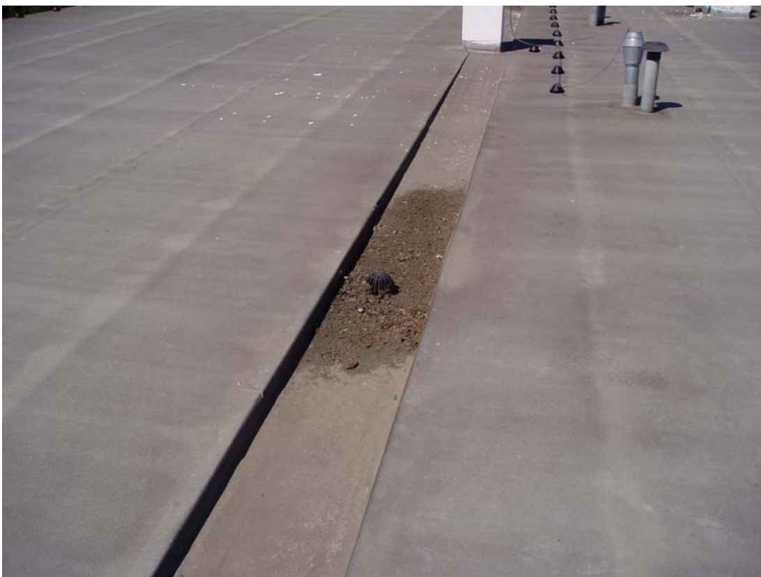
Foto1 – Pohled na HI střechy s mezistřeším žlabem
