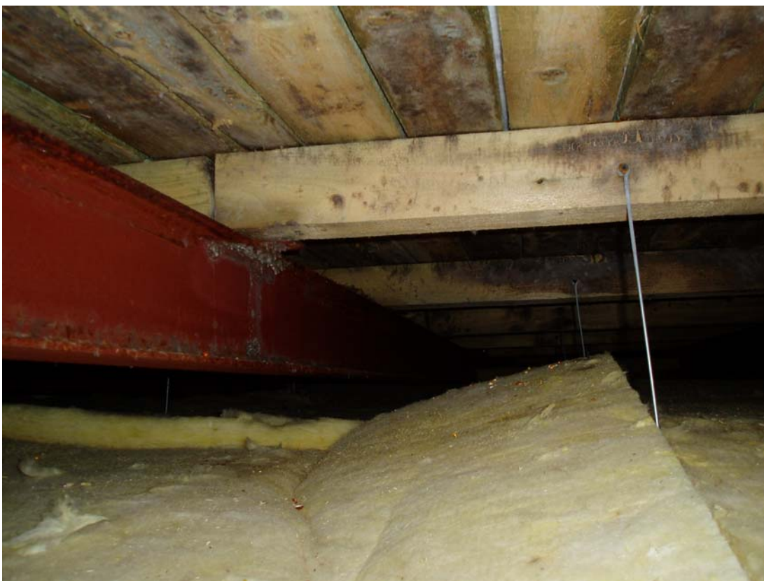
Foto 2 – Pohled na nosné konstrukce střechy z mezistřešního prostoru
