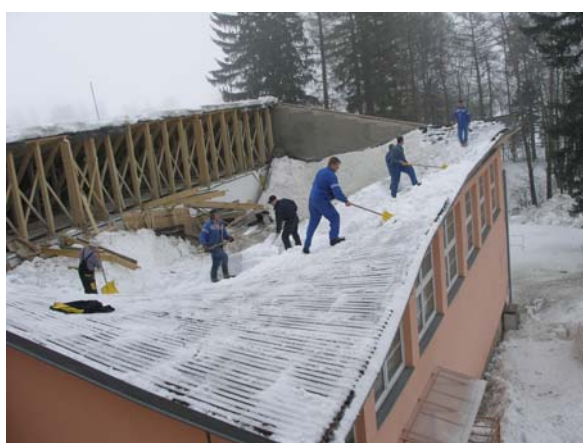
Foto č. 4 - Odstraňování sněhu na havarované části střechy
