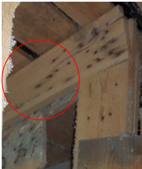
Foto č. 9 - Provedení spoje jen s 11-i hřebíky
