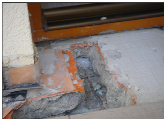
Obrázek č. 8 – Sonda pro ověření skutečného stavu
