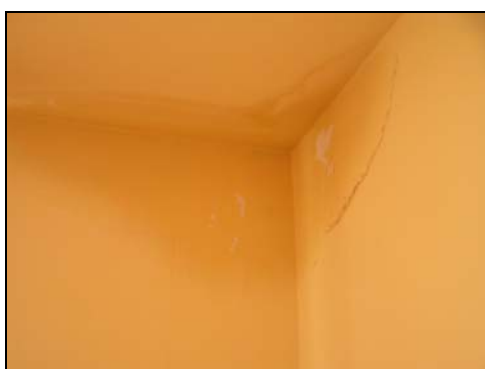
Obrázek č. 3 – Vlhké kouty obytných místností, fabiony, pata obvodové stěny
