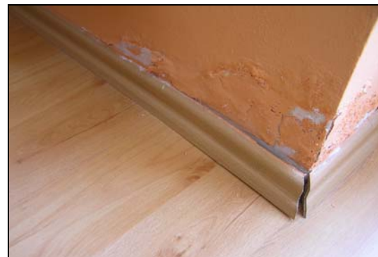
Obrázek č. 3 – Vlhké kouty obytných místností, fabiony, pata obvodové stěny
