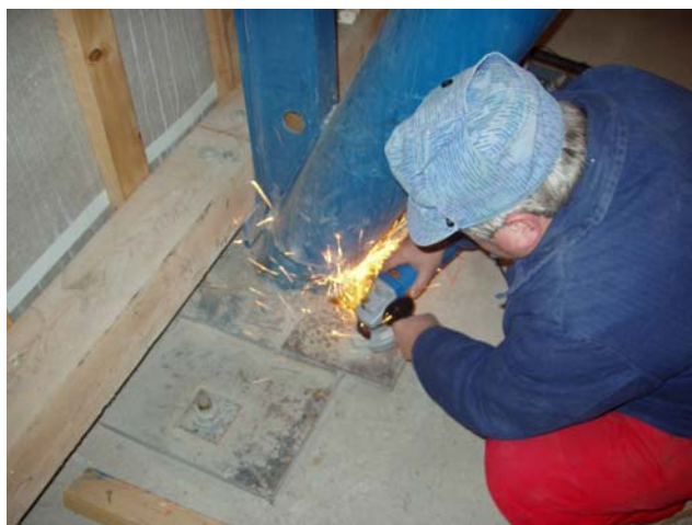
Obr. 4 Zabroušení horního povrchu šroubu
