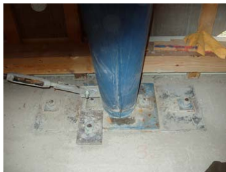
Obr. 3 Pohled na ukotvení ocelového sloupu
