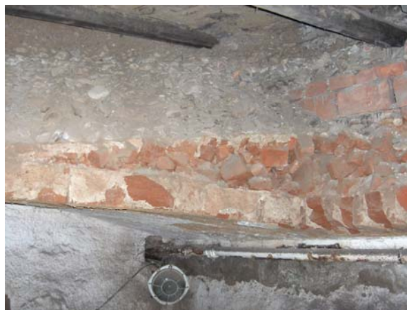
Obrázek č. 2 - Výplň cípu klenby z úlomků cihel a násyp ze štěrkopísku
