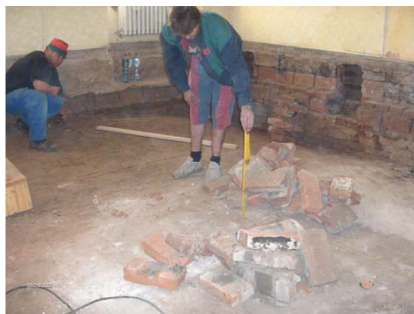
Obrázek č. 4 - Měření poklesu koruny klenby v sousední místnosti
