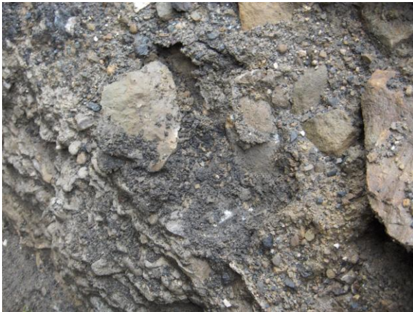
Foto č. 6 – Struktura materiálu nábrežní zdi
