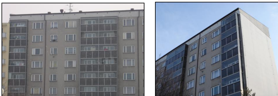
Obrázek č. 12 – Panelový bytový dům a sanovaná střecha
