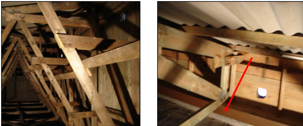
Obrázek č. 18 – Konstrukce vazníků pro nesení horního pláště
