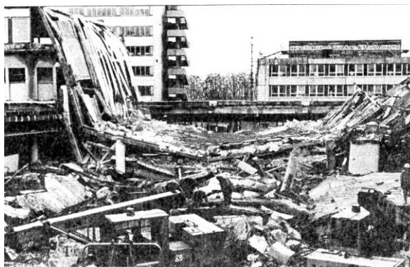
Foto 3 a 4: Pohled na havarovanou část haly v Uherském Hradišti vybudovanou z betonu s hlinitanovým cementem
