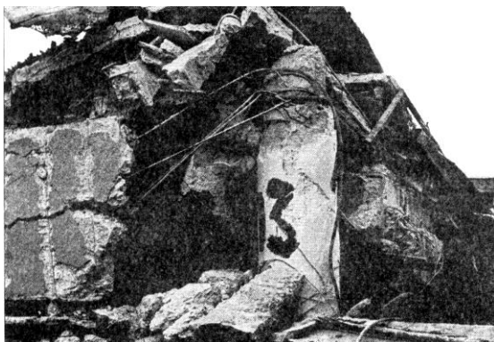
Foto 3 a 4: Pohled na havarovanou část haly v Uherském Hradišti vybudovanou z betonu s hlinitanovým cementem
